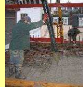
Dolej brakującą warstwę betonu
